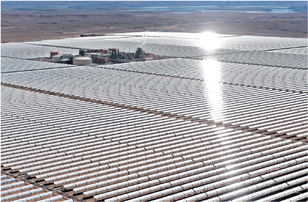
Das Solarthermie-Kraftwerk Noor 1 bei Ouarzazate in Marokko
