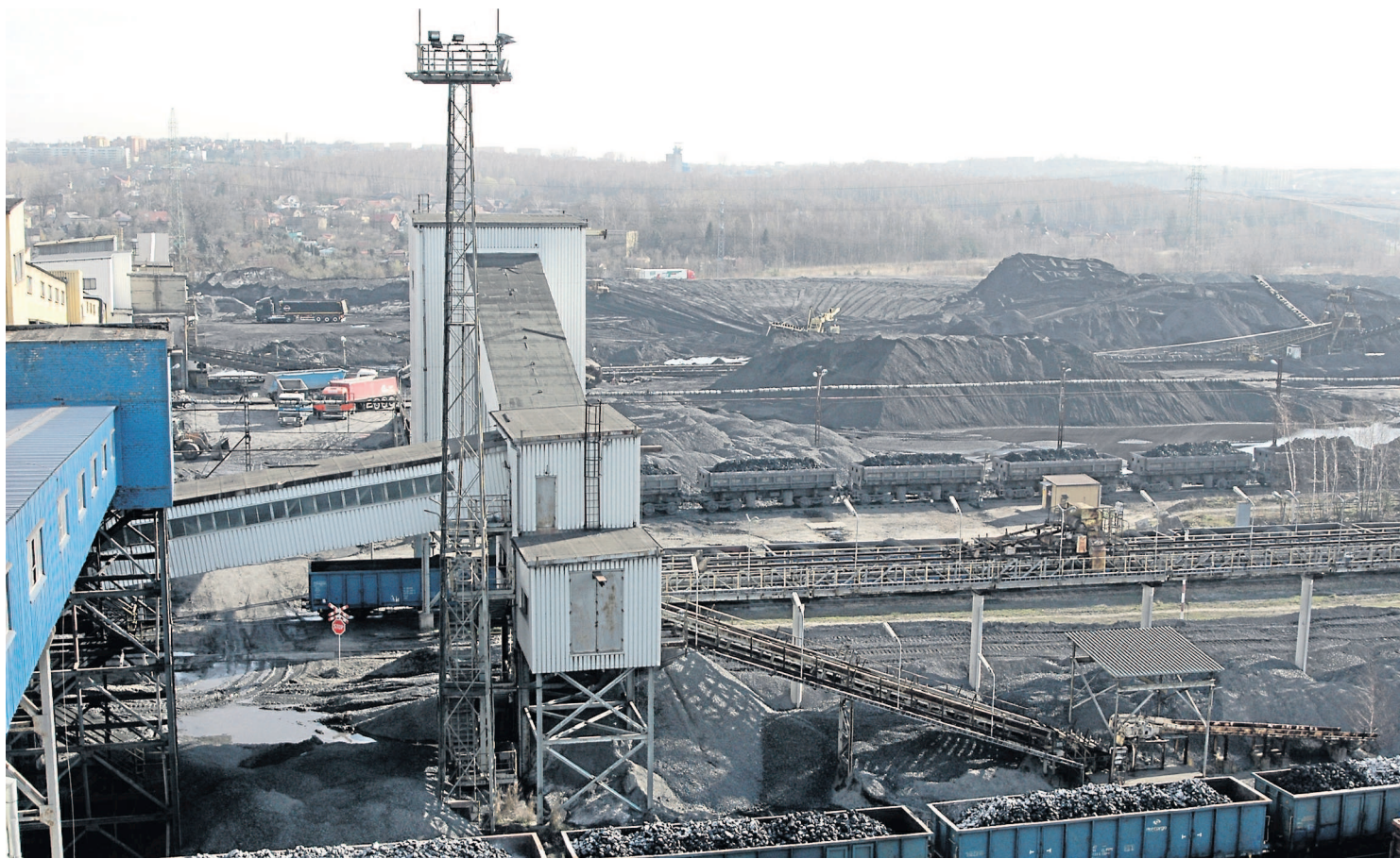
Im Bergwerk in Jaworzno reichen die Reserven bis 2064 – und gerade wird ein neuer Schacht gebaut.
